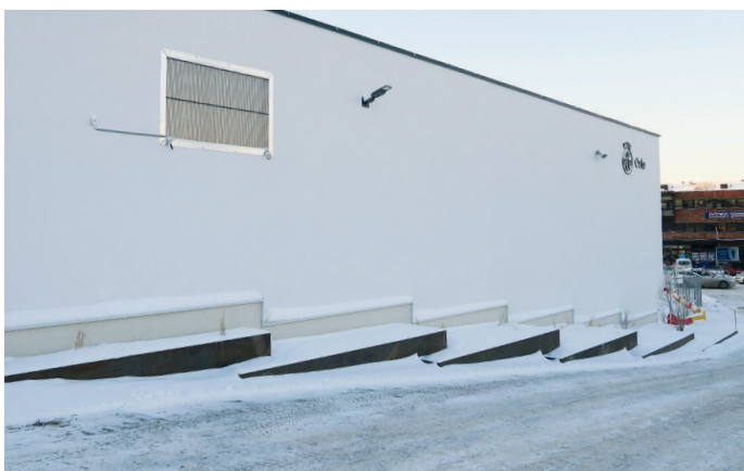
Bygget har pussede fasadeplater.
